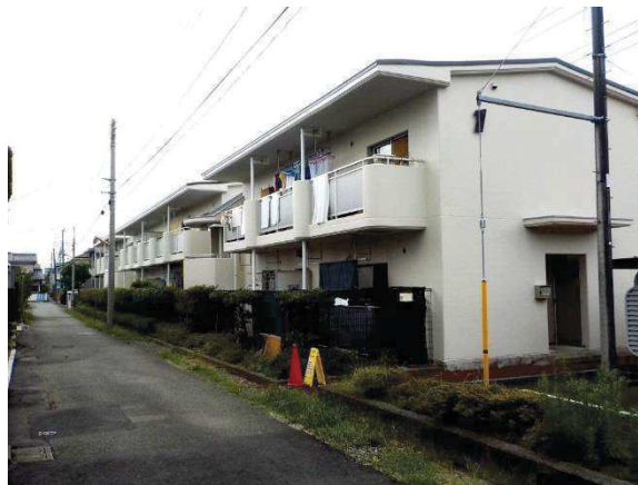
幸町七番住宅1号棟（外壁塗装改修工事後）
