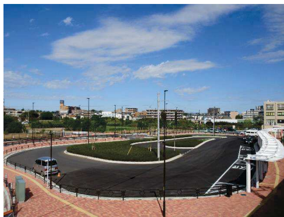
武蔵砂川駅前広場の様子
