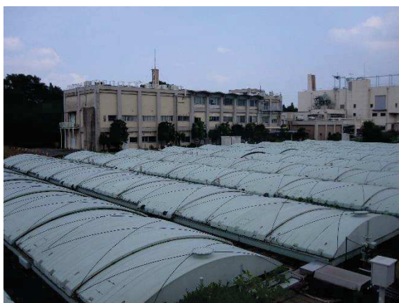
下水処理場の様子
