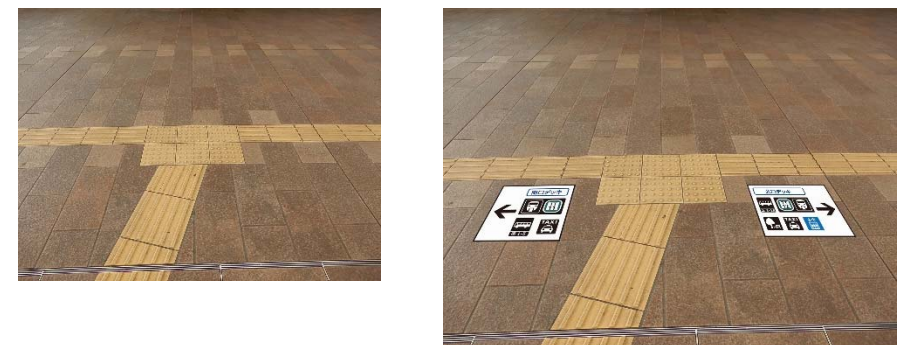
路面08/R02年度 左：現状 右：整備後
