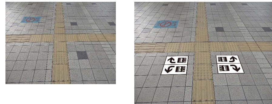
路面05/R02年度 左：現状 右：整備後
