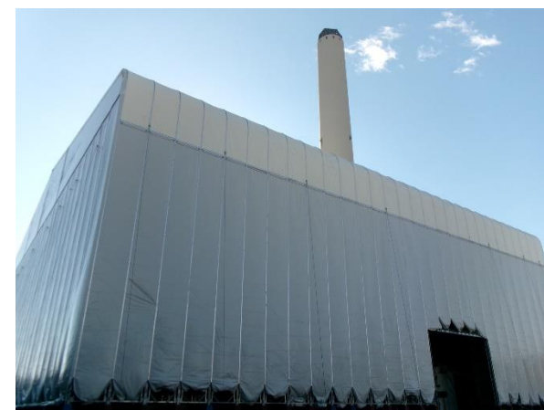
工場棟の全覆い仮設テントの外観
