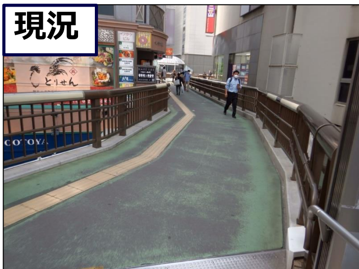
舗装の摩耗・ひび割れがみられる
