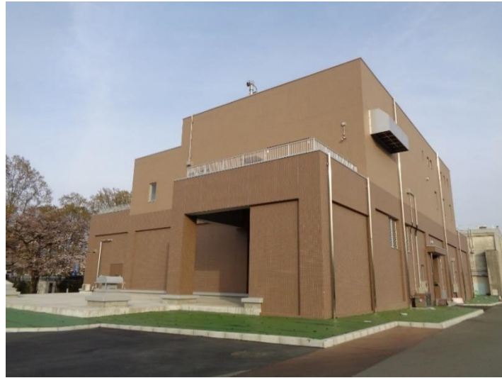
図3-3 下水送水施設
