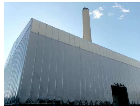
工場棟の全覆い仮設テントの外観
