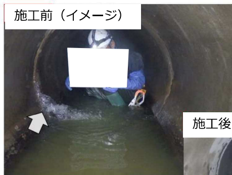
下水道管の補修
