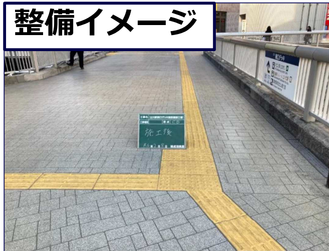
(南口デッキ・令和5年度整備)
