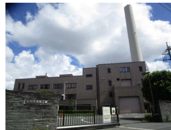
旧清掃工場の外観
