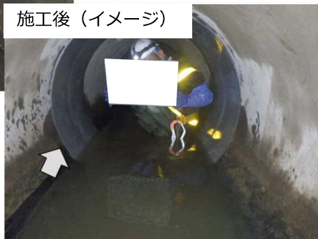
下水道管の補修
