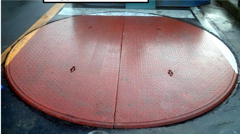
覆工板設置状況
