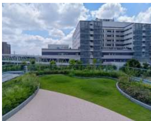
写真4-9 子どもと子育て家庭を総合的に支援する拠点の子育て支援・保健センター(愛称:はぐるりん)の屋上緑化
