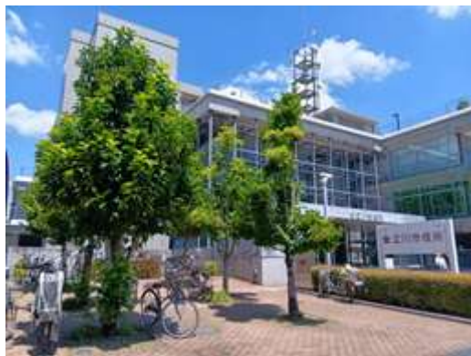
写真2-7 立川市役所の緑化
