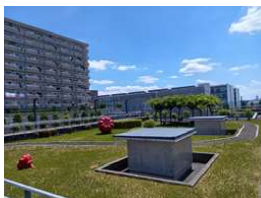
写真2-8 立川市役所の屋上緑化
