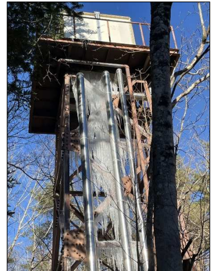
高架水槽の漏水 (令和 7 年度発生)
