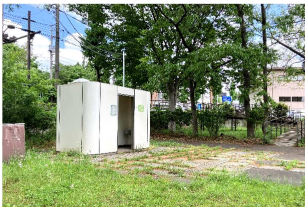
男女兼用トイレ、周辺も雑草が繁茂
