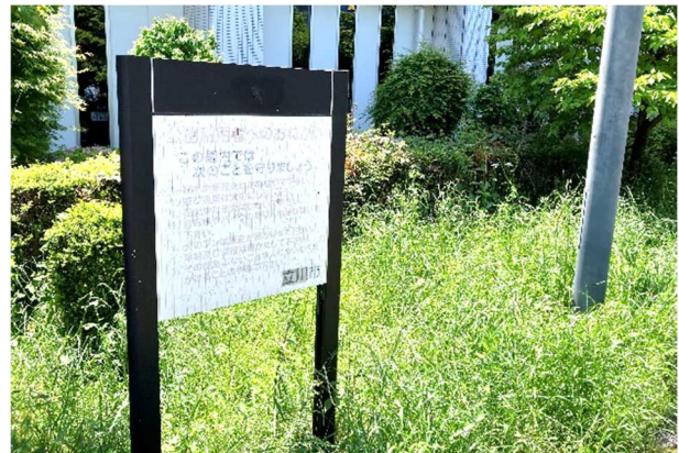
劣化で文字が判読しにくいサイン類
