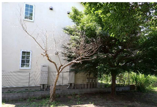
枯損木の残置
